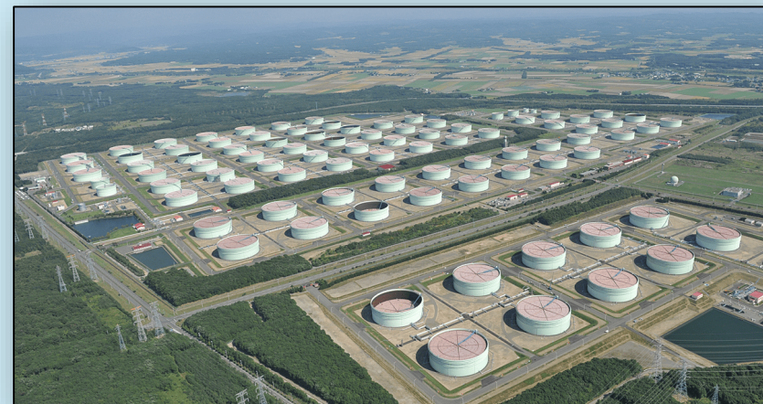
苫小牧国家石油備蓄基地（北海道）
