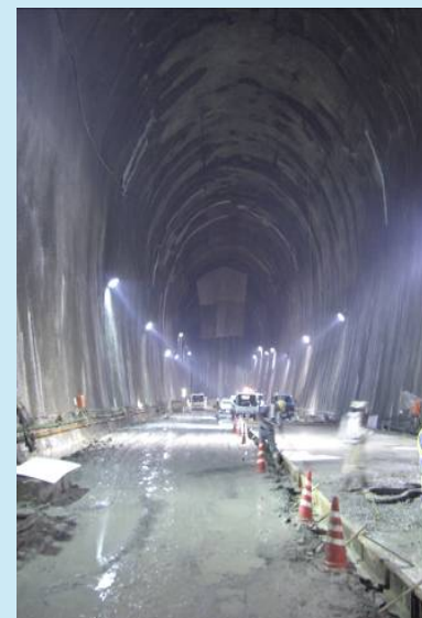
倉敷基地地下貯槽の様子 (建設時) ※2
